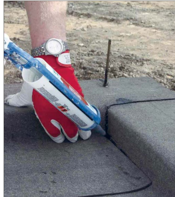
Nurkkien tiiviys varmistetaan tarvittaessa Tiivistysliimalla K-36
